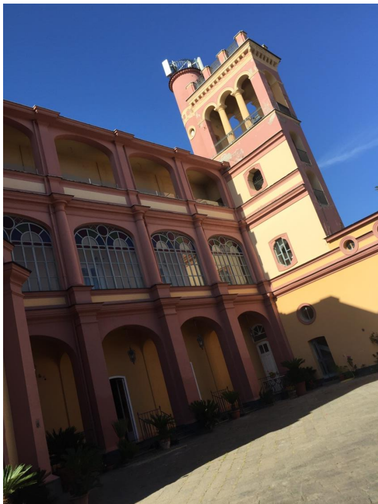
Figura 3: Palazzo Coppola, facciata interna.
